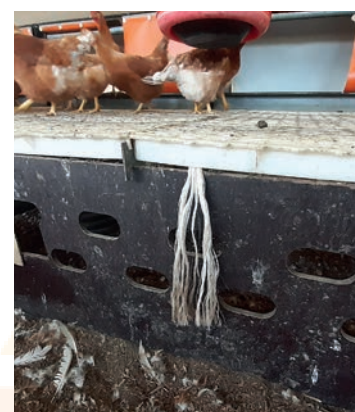
Figure 11: Ficelles blanches dans un bâtiment de production
